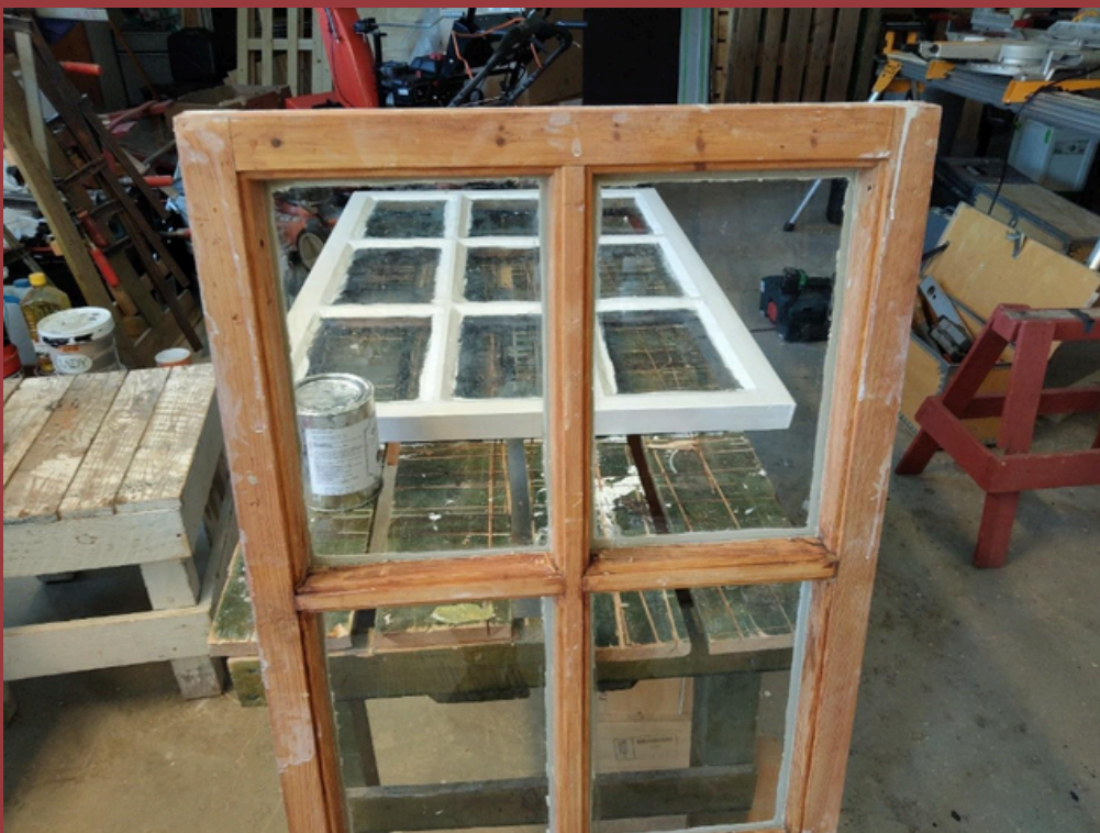
Kitting av glassvindu, Kautokeino bygdetun
